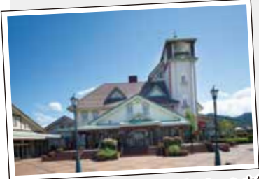
道の駅あいとうマーガレットステーション本館内
